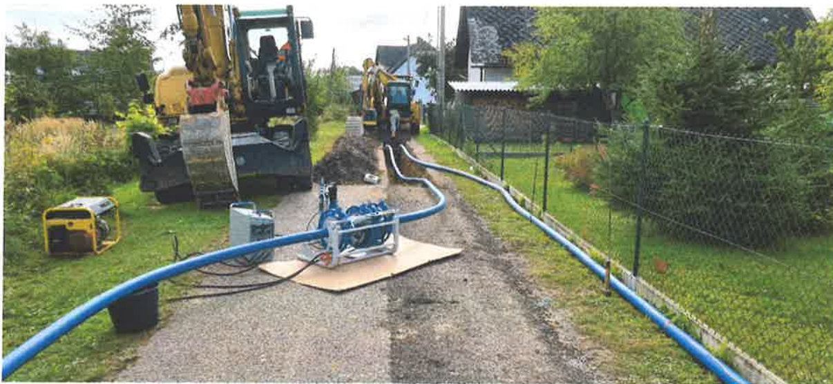
Stavební úpravy vodovodu Chvalkovice – Výhled
