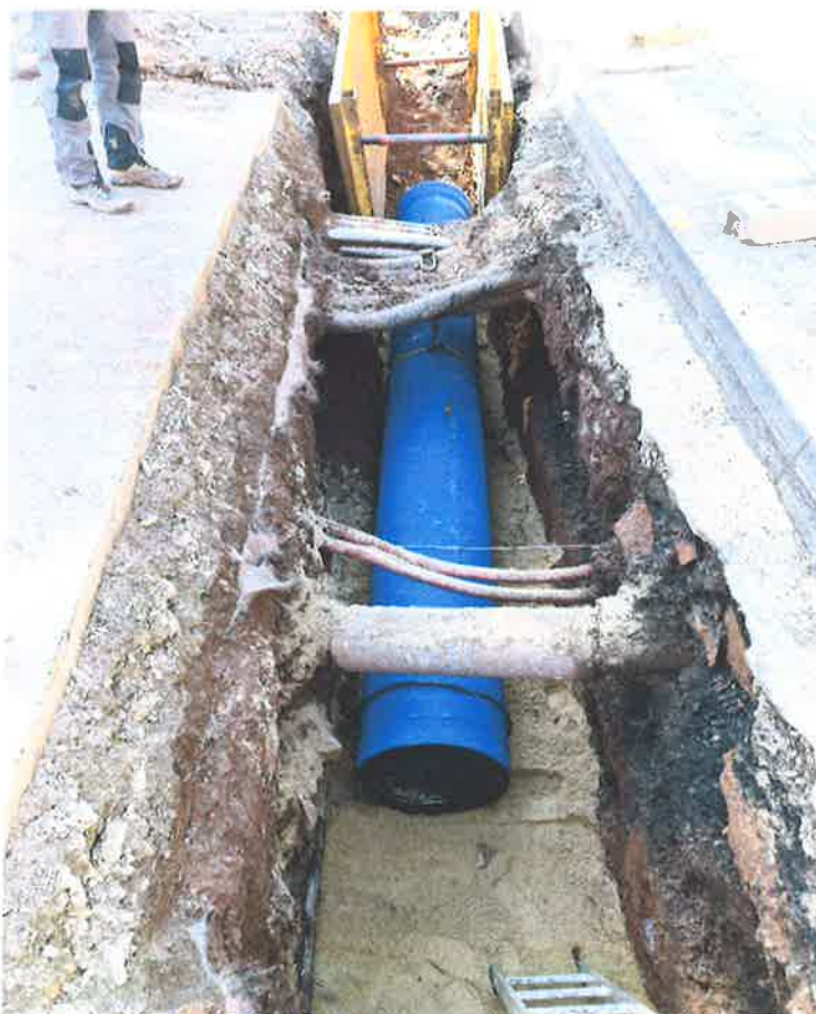
Oprava přiváděče VSVC Náchod
