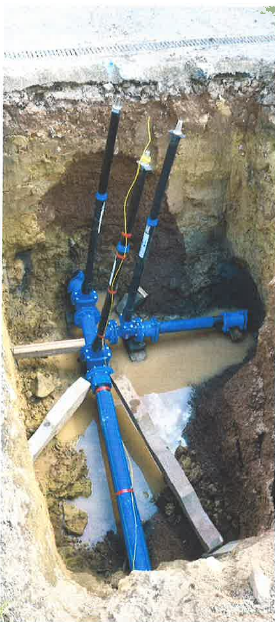
Oprava vodovodu Hlavňov
