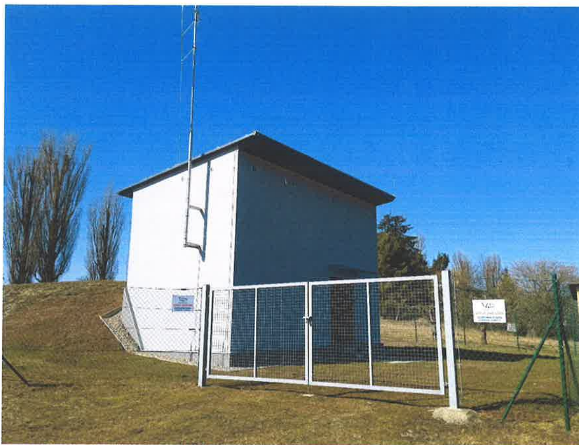
Rekonstrukce vodojemu Proruby 160 m 3
